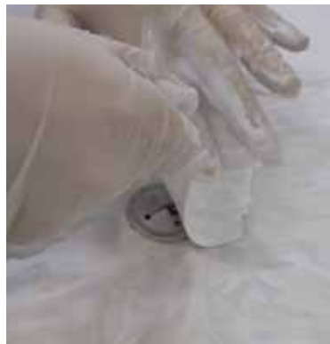
Scolare l'eccesso e procedere con la sigillatura di giunti e rondelle Drain the glue in excess and seal joints and washers
